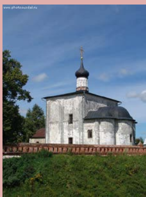
. 76. Церковь свв. Бориса и Глеба в Кикдеше, современный вид
